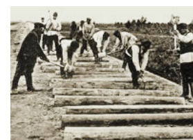
図6 シベリア鉄道の敷設
